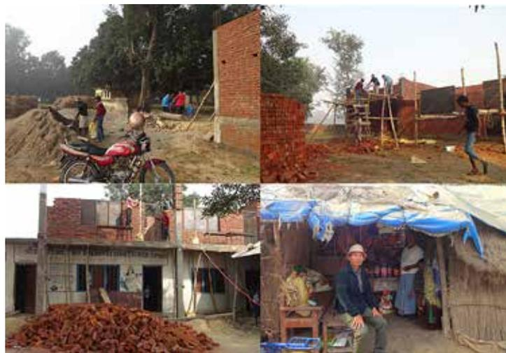
ラマさんに Garden Lodge の近くの店で昼食をご馳走になる。午後はシリ・アマリ校を訪問。一階は授業中の教室の二階に新しい教室をレンガ積み立てを建築作業している。一階から二階にコンクリートを上げたり鉄筋棒で柱を作り上げているけど、作業工具や作業機械が無く手作業である。
